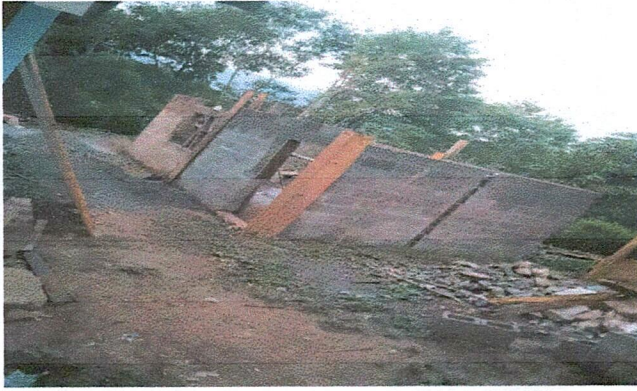
Foto 1: Reparación o sustitución de area de cocina.
