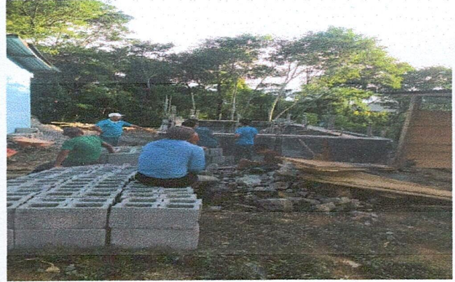
Foto 2: Reparación o sustitución de area de cocina.
