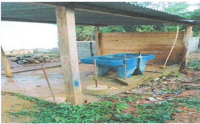
Foto 1: MEJORAMIENTO Y AMPLIACION DE ESTRUCTURA DE LAVAMANOS.
