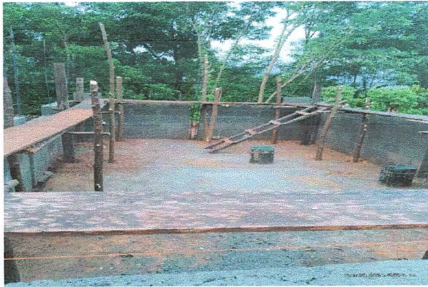
Foto 3: Reparación o sustitución de area de cocina.
