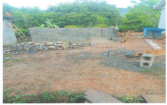
Foto 2: MEJORAMIENTO Y AMPLIACION DE ESTRUCTURA DE LAVAMANOS.
