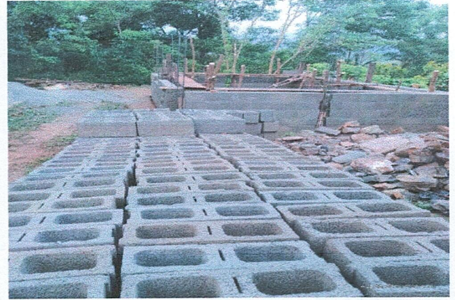
Foto 4: Reparación o sustitución de area de cocina.
